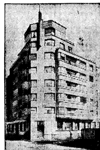
Nuevo edificio en construcción en el paseo de Sarasate, para la Caja de Ahorros Municipal.
