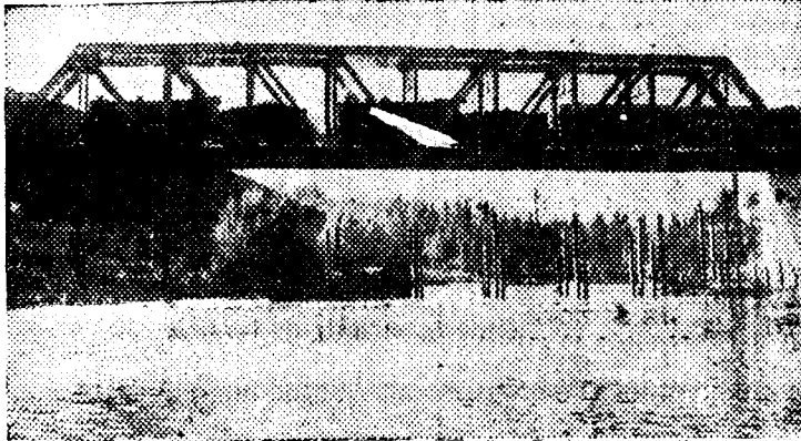
Puente sobre el río Duero
