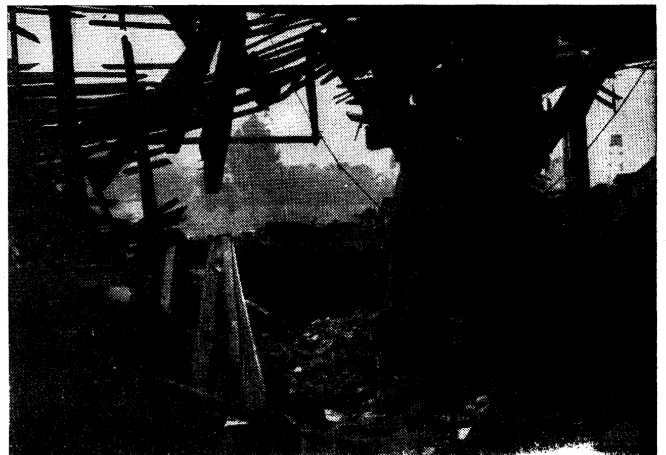
Planta alta del cuartel de Sama, en que se aprecian las cubiertas destruidas
