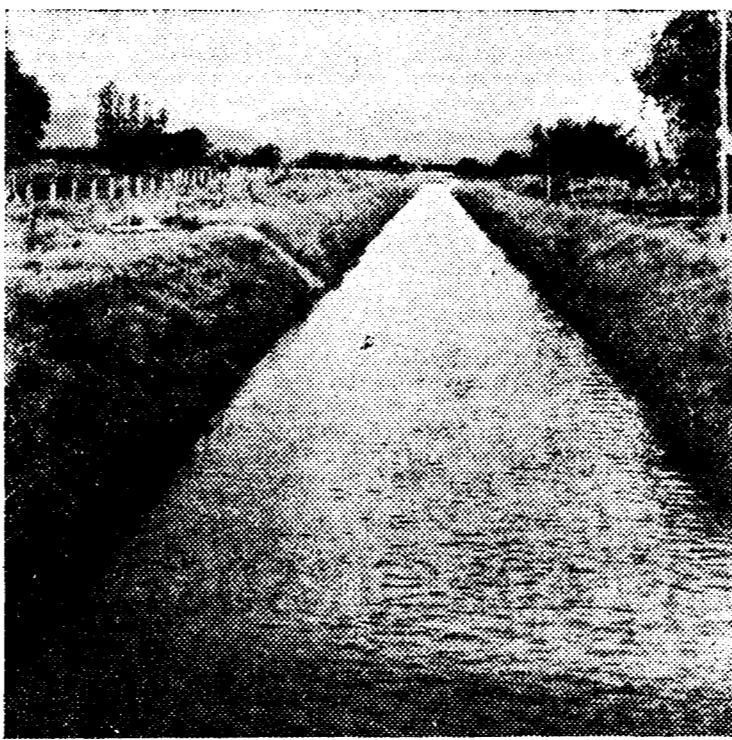
Canal en tierra con solera revestida
