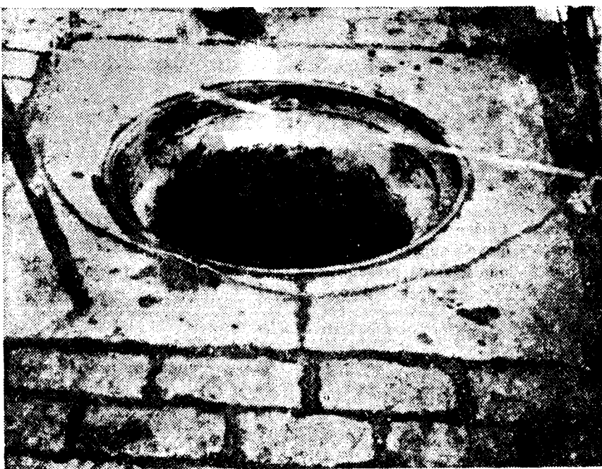
Escondidos en estos pozos, que se han mandado tapar ayer, los ladrones tiraban de las patas de las ovejas que iban al Matadero.
