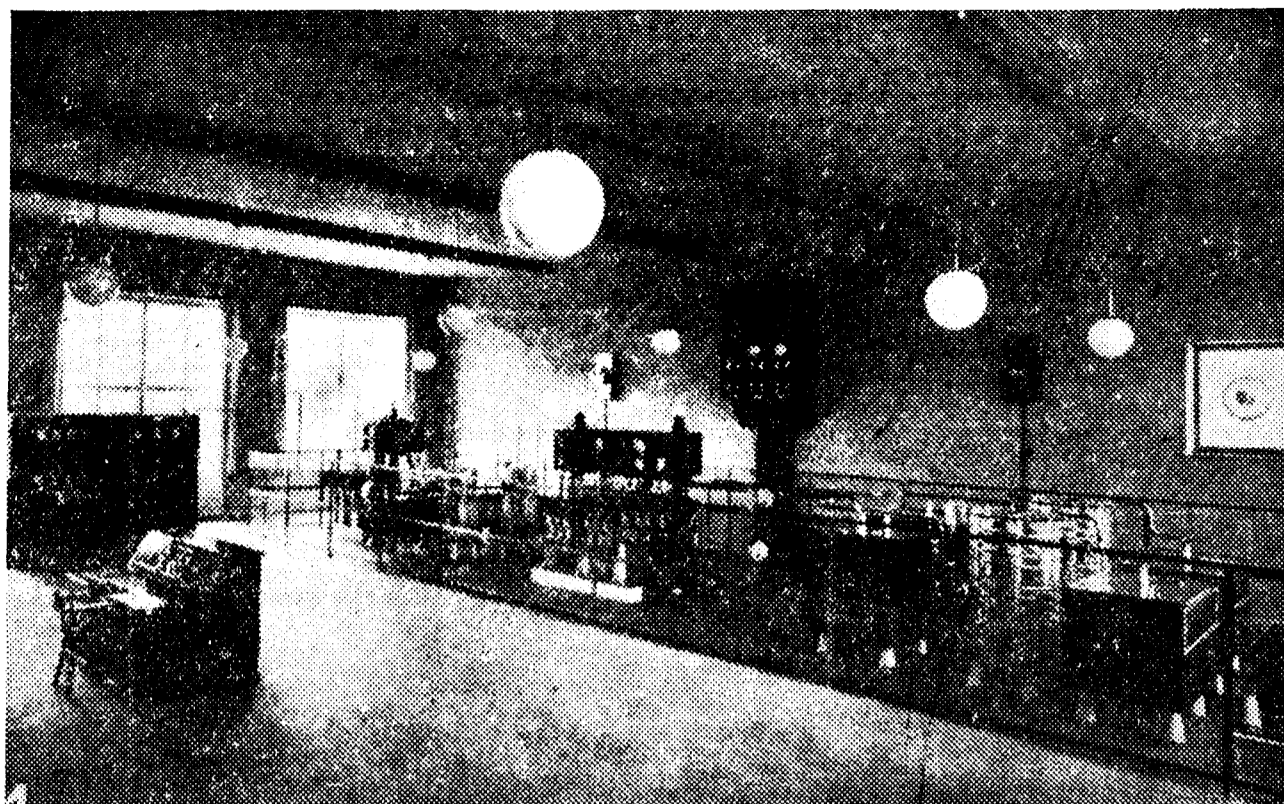
Sala de transmisión de la gran emisora de Praga, instalada por la casa Standard Eléctrica
