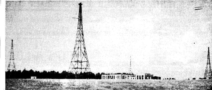
Bello conjunto de antenas instaladas por la Compañía Marconi en el importante Centro de Radiodifusión de Brookmans Park. Las cuatro esbeltas torres que muestran la fotografía corresponden a dos modernos transmisores de 50 kw. cada uno
