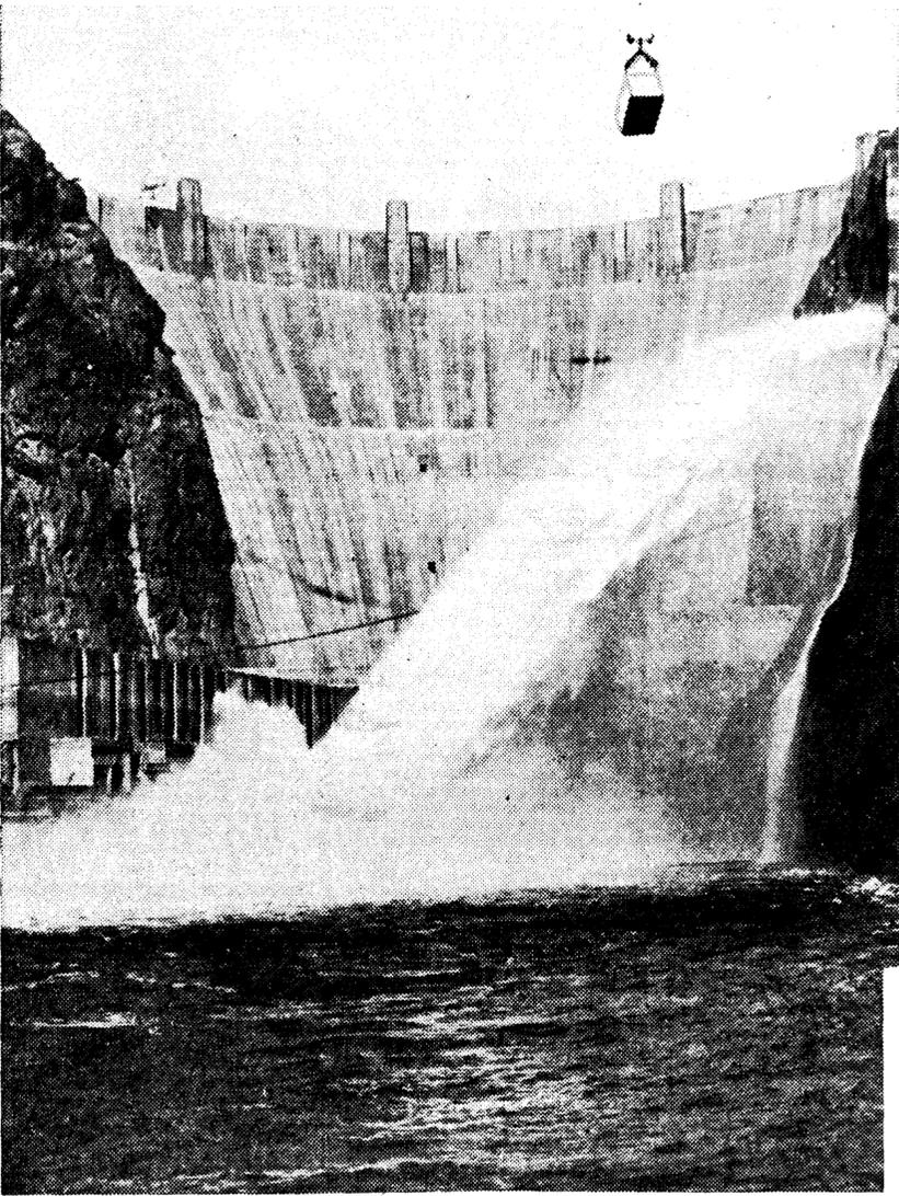
← La gigantesca presa de Boulder (Colorado), tiene doce compuertas para dar salida al agua sobrante. He ahí una de dichas compuertas durante las pruebas. El caudal que arroja alcanza la enorme cifra de 40.000 litros por segundo (Foto Vidal)
