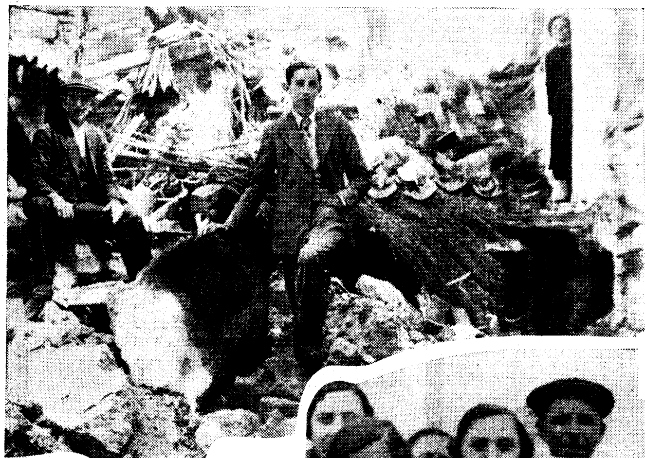
En Arjona (Jaén) se ha derrumbado parte de una casa a consecuencia de las pasadas lluvias. En la foto de la derecha se ve al obrero Manuel Mena Gay (x), que se dió cuenta de la inminencia de la catástrofe y avisó a los vecinos de la casa, que le rodean en la foto, quienes evacuaron precipitadamente el inmueble, gracias a lo cual no hubo que lamentar desgracias personales (Fotos Ortega)
