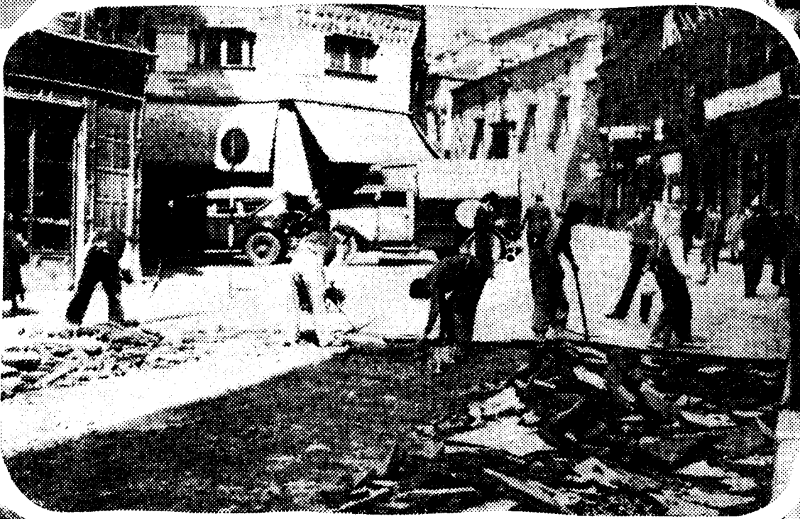
En la calle del Carmen han comenzado los trabajos preliminares para preparar el paso del tranvía (Foto Santos Yubero)
