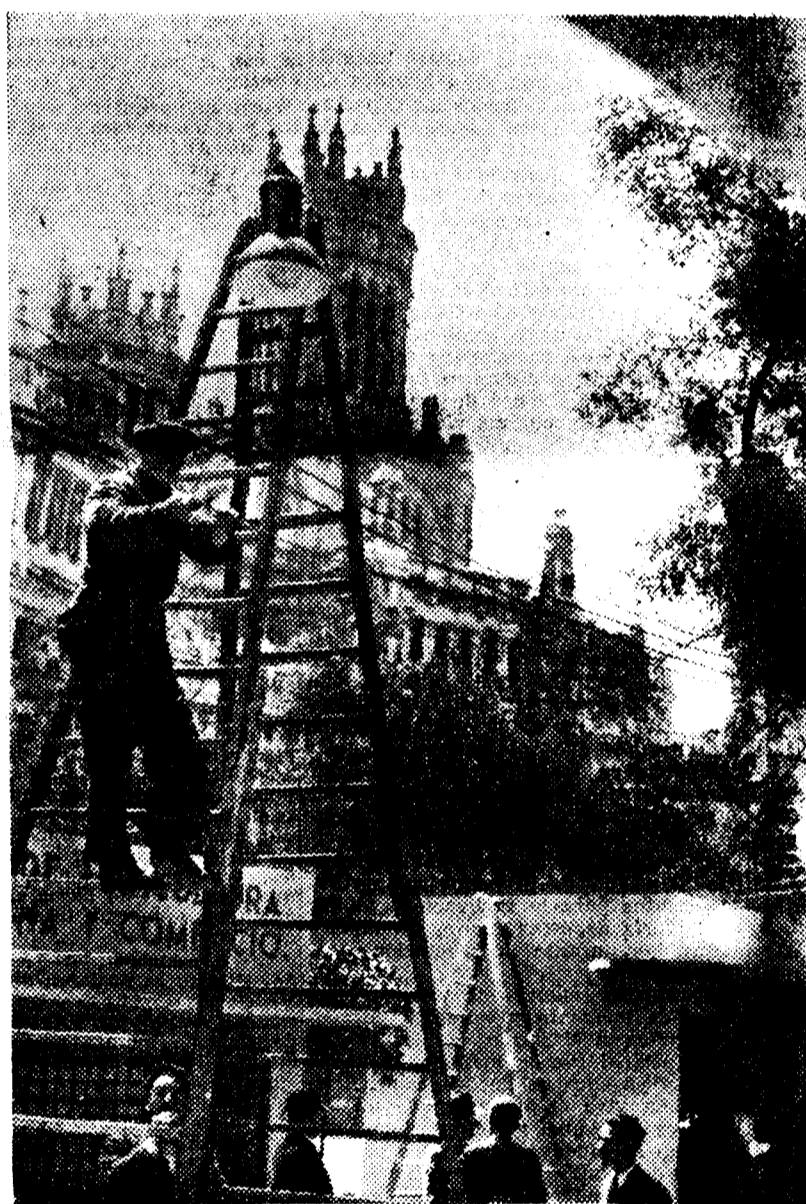
Los obreros electricistas trabajando en las instalaciones de alumbrado que han sido montadas en el paseo de Recoletos con motivo de la Feria del Libro, que será inaugurada hoy por la mañana. A la derecha: Brigadas de obreros dando los últimos toques a los «stands» instalados
