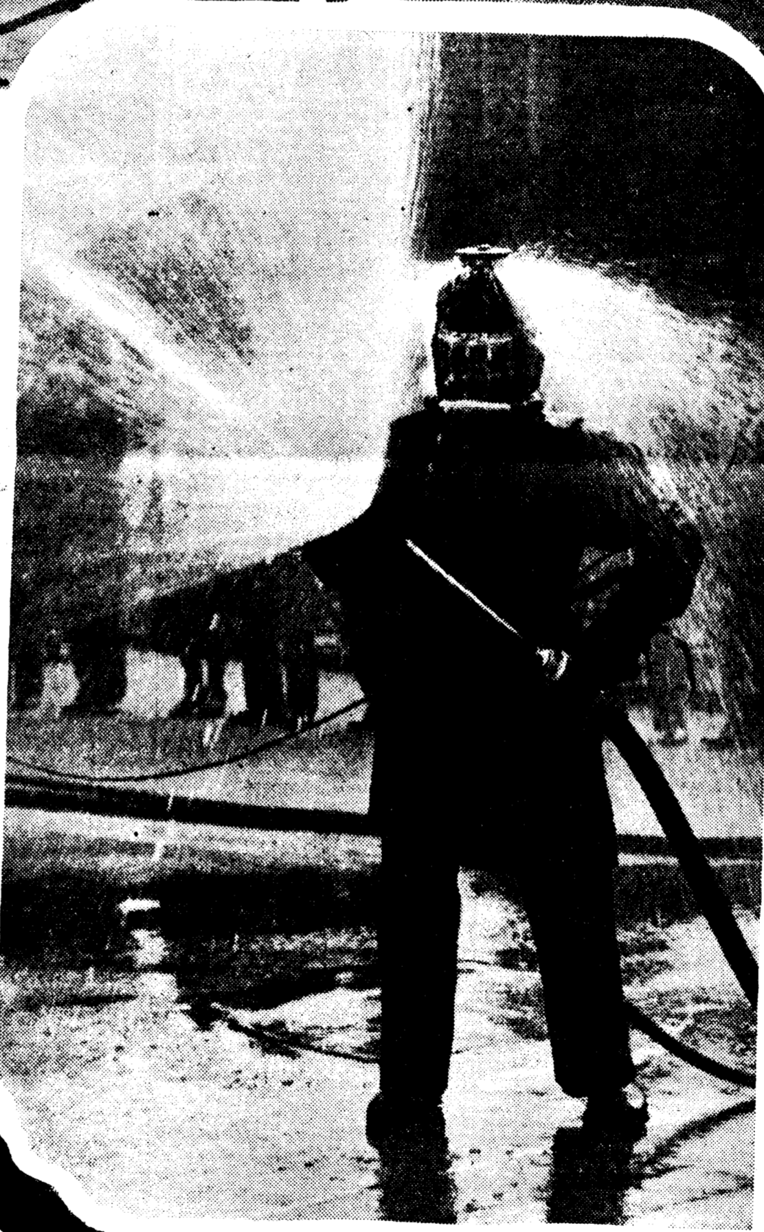
En la Exposición que se celebra en el salón Kaiserdamm, en Berlín, se han hecho prácticas de esta nueva escafandra de bombero, llamada «velo de lluvia», con la cual el bombero está continuamente rodeado de agua, lo que le permite acercarse al foco del incendio (Foto Ortiz)
