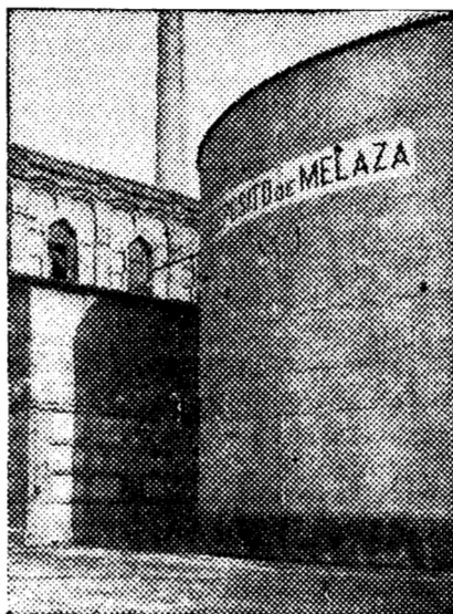
Uno de los enormes tanques donde se almacenan las melazas en la Azucarera de Madrid. (Foto Ragel)
