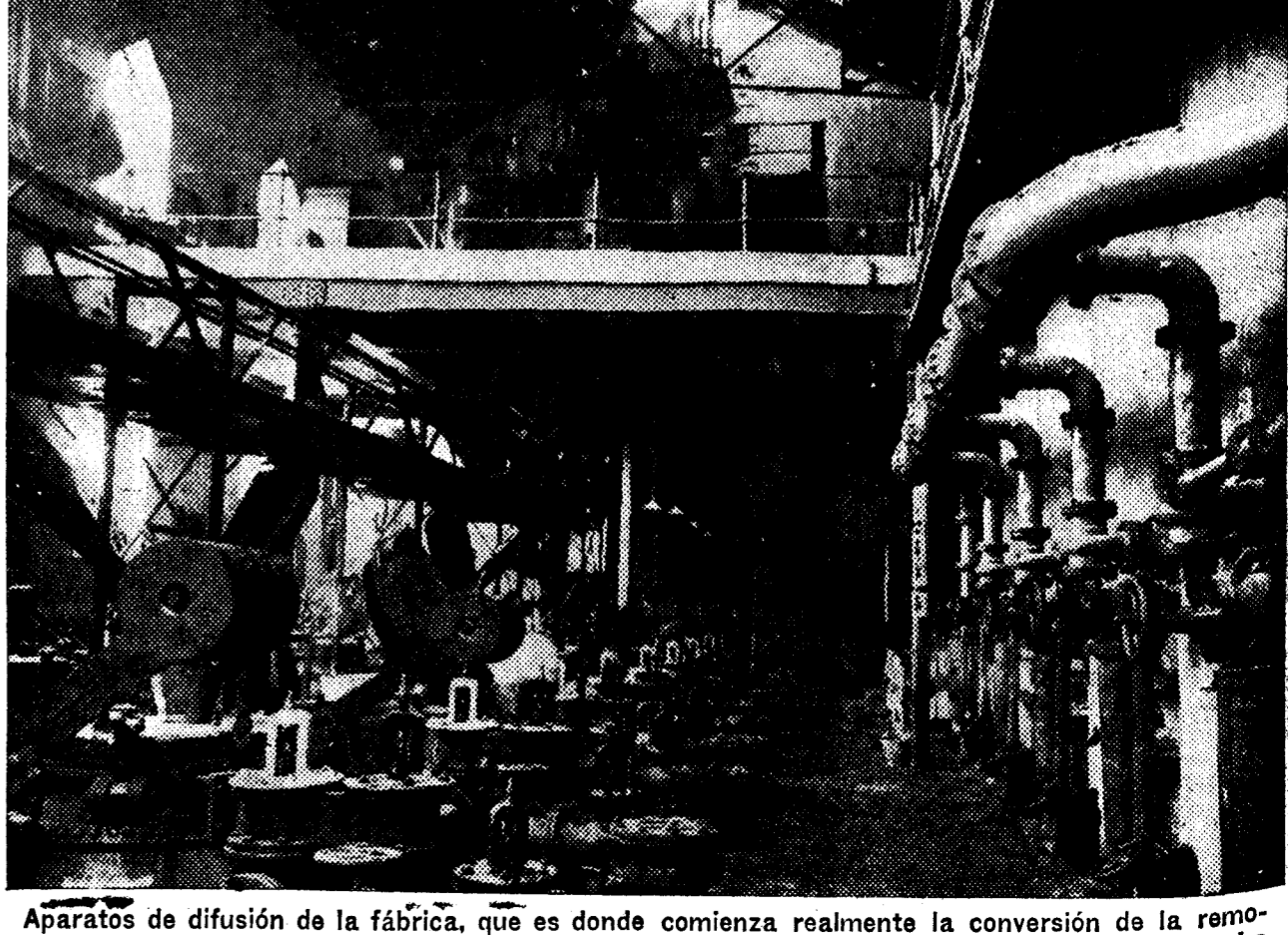
Aparatos de difusión de la fábrica, que es donde comienza realmente la conversión de la remolacha en azúcar. Los que aparecen en la foto no se parecen en nada a los primeros que tuvo La Poveda, pues son la última palabra de esta clase de maquinaria, y los instaló la actual Sociedad propietaria de la fábrica. (Foto Ragel)
