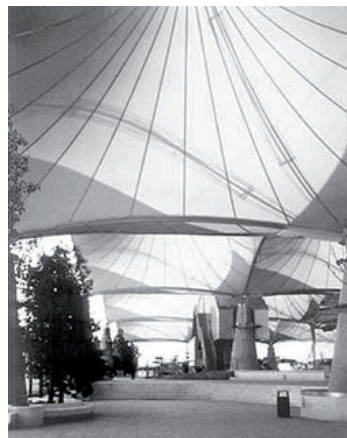
Fig. 10. El Palenque, Sevilla. Arquitecto: José Miguel Prada Poole. Carpas de pvc cubren un amplio espacio abierto.
