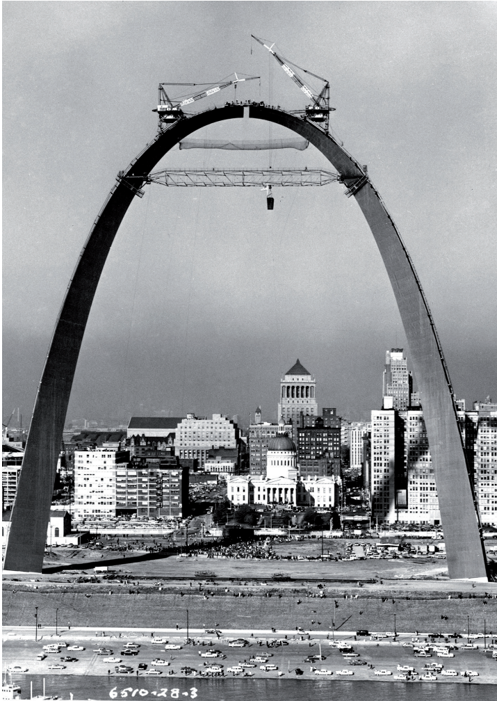
Fig. 7. Colocación de la última dovela del arco.
