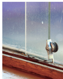
Fig. 14. Esquema de ventilación cruzada de la Casa Huarte. Sección transversal. Dibujo: Pablo Olalquiaga. Fig. 15. Casa Huarte. Detalles de la carpintería sin cerco tipo Pierson. Fotografías: Miguel de Guzmán.
