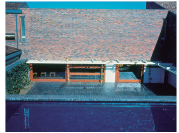
Fig. 5. Casa Huarte. Fotografía: Archivo Corrales.
