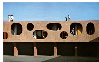
Fig. 20. Obras en el edificio del Secretariado, Chandigarh. Le Corbusier. Œuvre complète Volume 8: 1965-1969.
