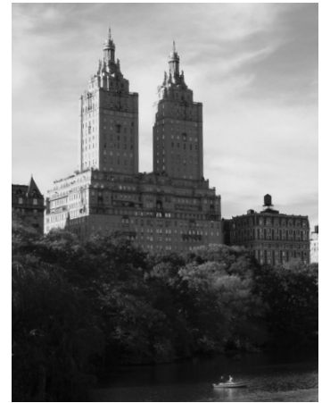
Fig. 5. Edificio San Remo. Twin towers block .
