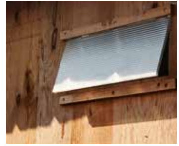
Fig. 5. Refugio de tablero de madera, detalles, agosto 2016.
