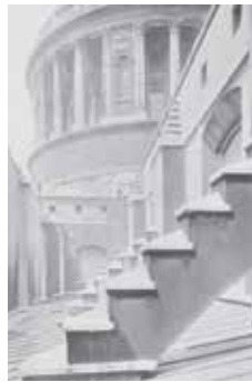
Fig. 4. Estructura de cubierta del Sheldonian Theatre. Fotografía del autor. Fig. 5. Contrafuertes de la catedral de San Pablo, ocultos por el muro de la izquierda. Ilustración 94 de An Inventory of the Historical Monuments in London, Volume 4, the City . Londres: HMSO, 1929.
