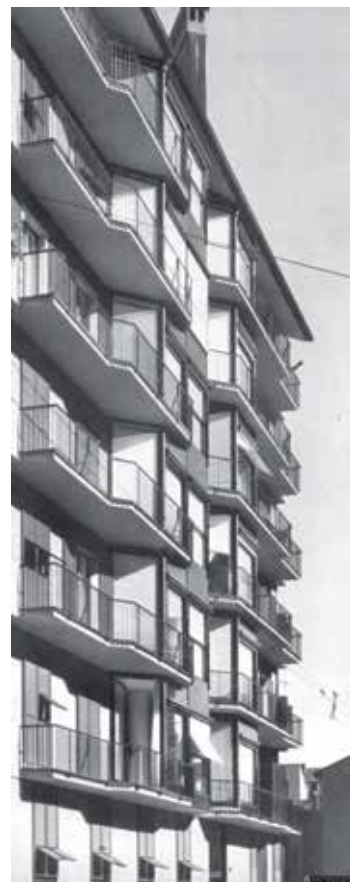
Fig 7. Fotografía de la fachada. Domus 380, 1963.
