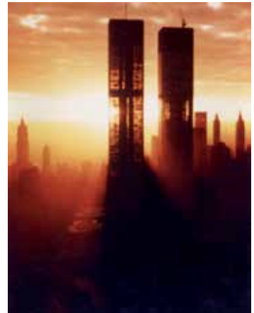
Fig. 3. Las Torres Gemelas durante su construcción.
