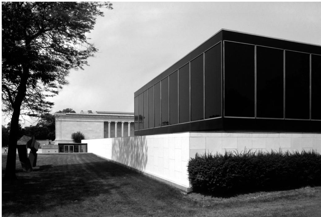
**Figura. 253.** La nueva adición de la galería de Arte *Albright Knox* en primer plano, con el edificio original al fondo, con el zócalo que nace del edificio antiguo, y el volumen de acceso conectado por medio de un conector específico. En *Albrght Knox and the Star-chitect Conundrum: The Process That Should Make You Worry*, por D. Steele, en *Buffalo Rising*, 2014
