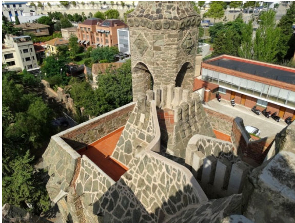
Merlets del terrat de la torre.
