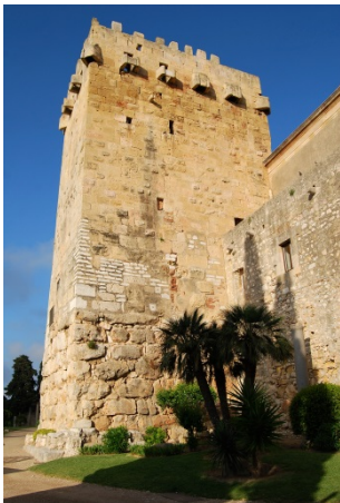
Torre de la muralla de Tarragona
