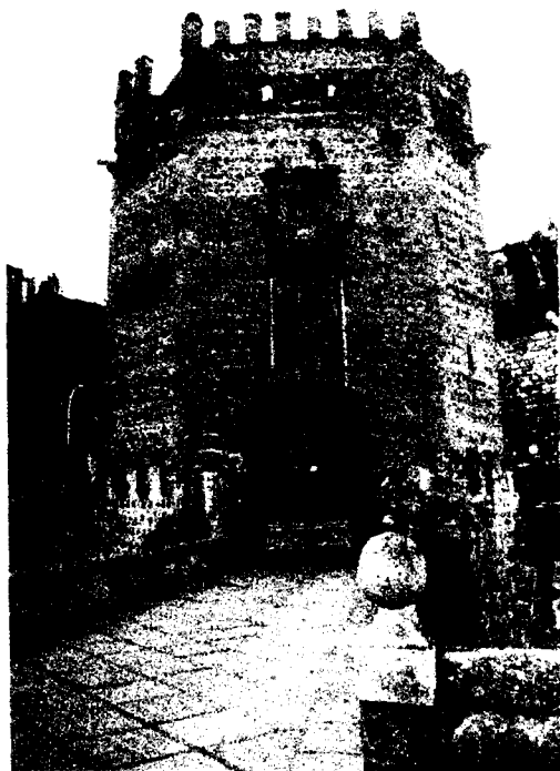
FIGURA 8.a. Torre interior de Alcántara.
