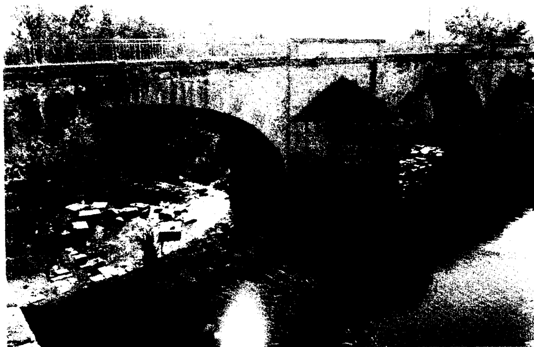
FIGURA 2. Arcos asentados sobre zampeado. Puente de Montalbán. Foto A. Malalana.
