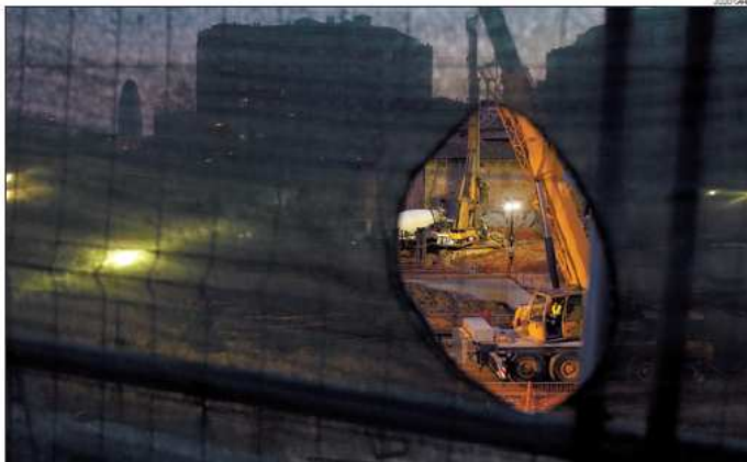
» Una excavadora, vista desde el oficio de una valla, trabaja en los terrenos donde se construirá la estación de Sagrada, ayer.
