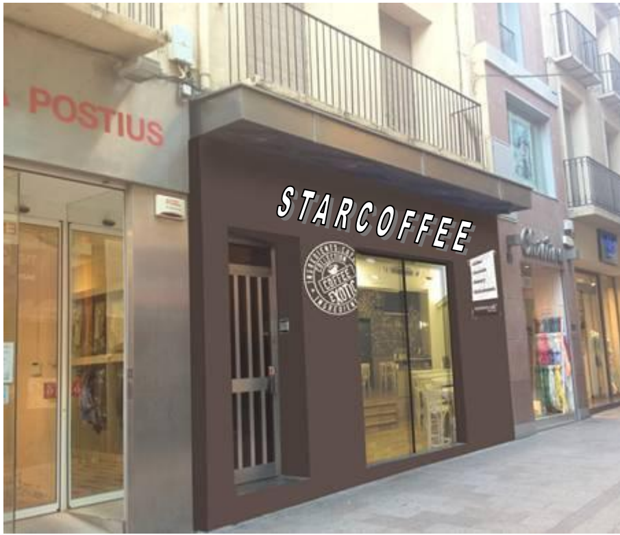
Il·lustració 8: mostra façana Carrer Carne
