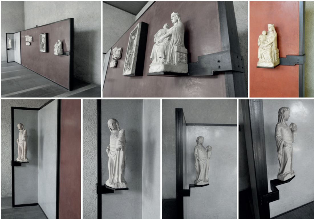
Figura 9. Madonna con niño. Maestro de San Anastasia. Primera mitad del siglo XIV. Museo de Castelvecchio, Verona, Italia. Soportes de acero diseñados por Scarpa para obras de arte que se extienden desde el bastidor de acero de los paramentos.
