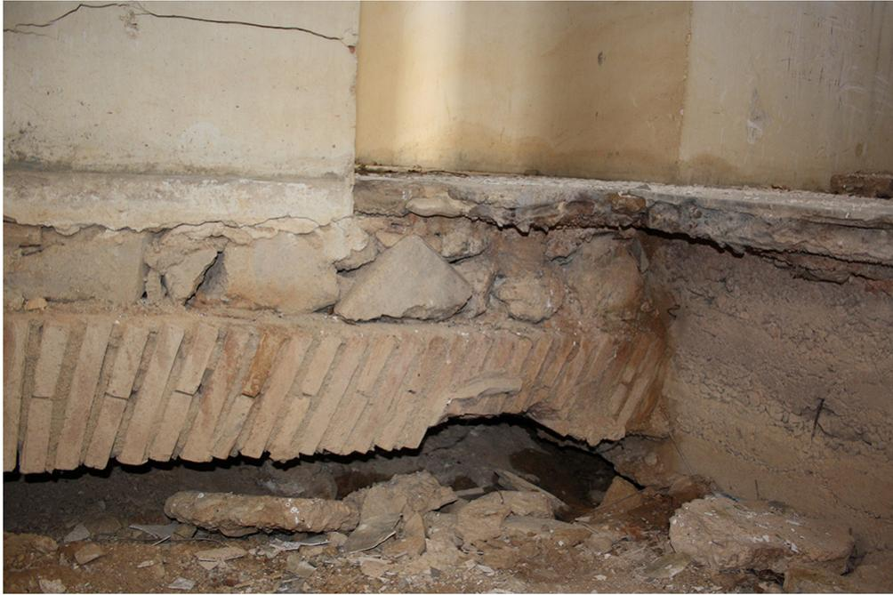
Figura 5. Vista del sistema de cimentación mediante arcos de descarga de ladrillo arriostros con vigas de hormigón.
