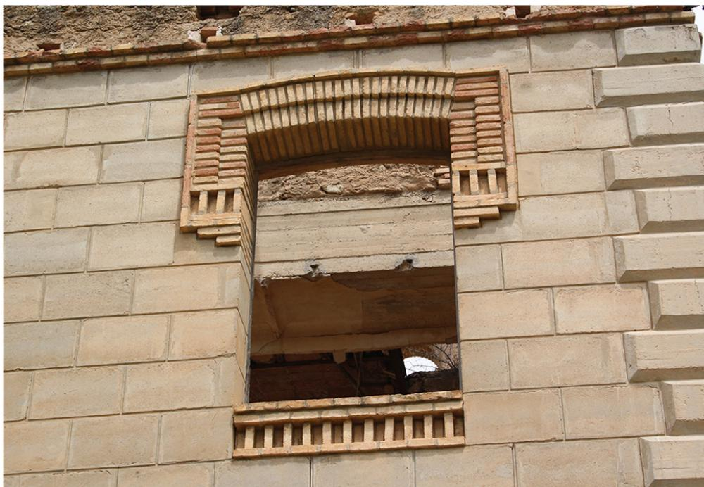
Figura 10. Resolución de dinteles y alfeizares de los vanos con ladrillo cerámico.
