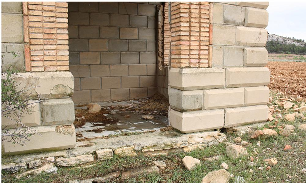
Figura 7. Utilización de piezas de piedra artificial en el zócalo del edificio.
