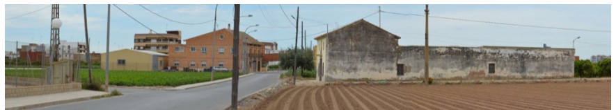
Frente urbano apenas visible de Borbotó Norte A1. CVC_200m Fotografía del autor 2015
