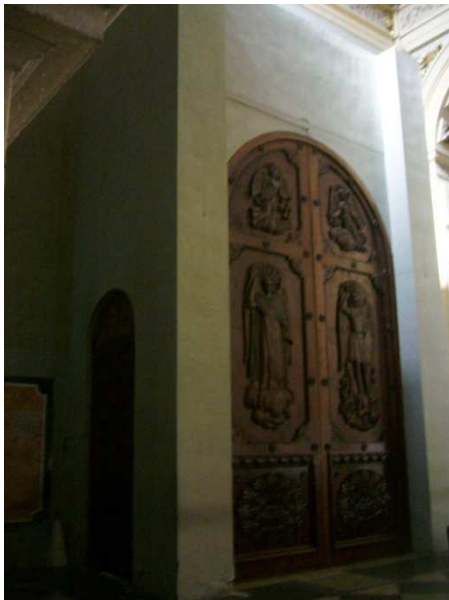
|Fig III.23. |: Puerta de entrada y laterales
