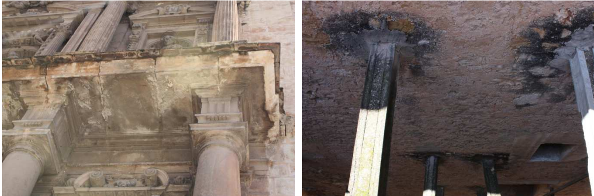
[Fig.V.60.]: Detalle fachada principal (izquierda) y detalle fachada oeste (derecha)
