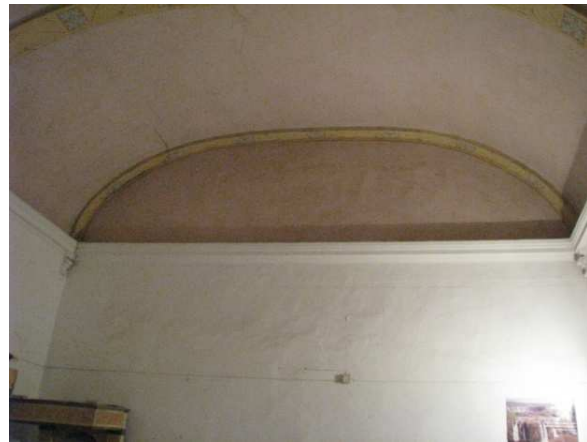
|Fig III.18. | : Bóveda del segundo piso de la sacristía
