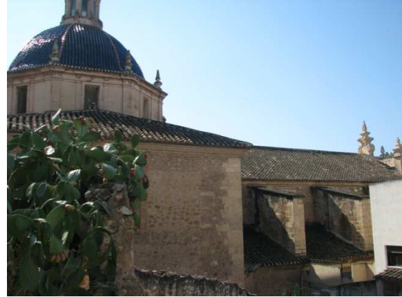
|Fig A.02.|: Fachada sur de la iglesia
