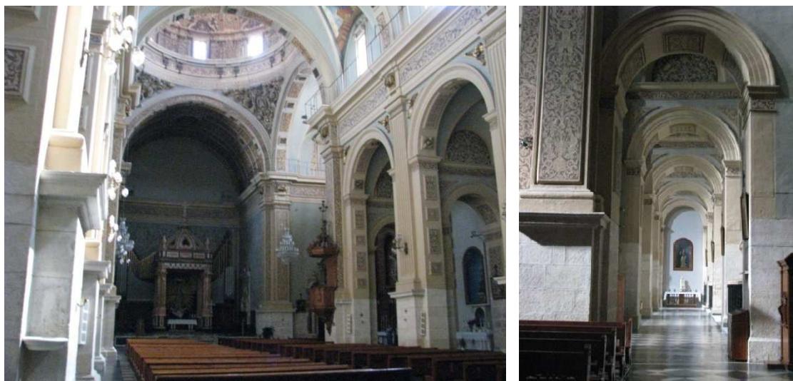
|Fig III.13. |: Vista nave central de la Asunción.
