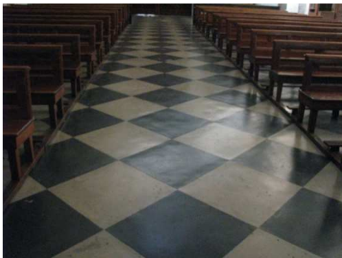
[Fig III.26. |: Pavimento nave central
