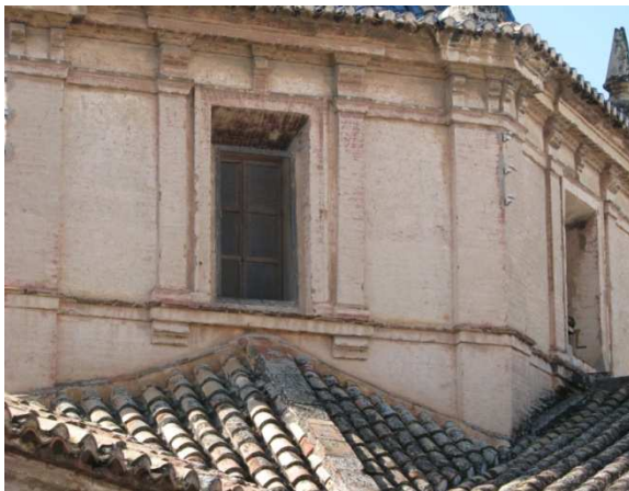
|Fig A.03.|: Detalle ventana de la cúpula
