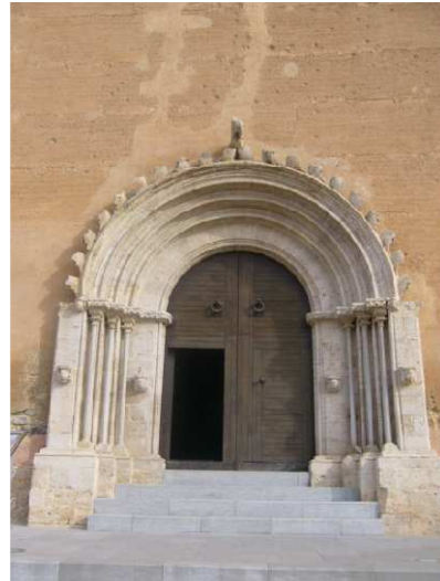
| Fig II.33. |: Detalle puerta de acceso a la iglesia de la Sangre
