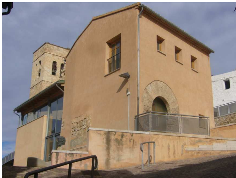
| Fig II.36. | : Edificio Ca la Villa Vella
