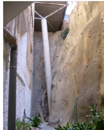
[Fig III.7.]: Vista aérea del corte del terreno fachada
