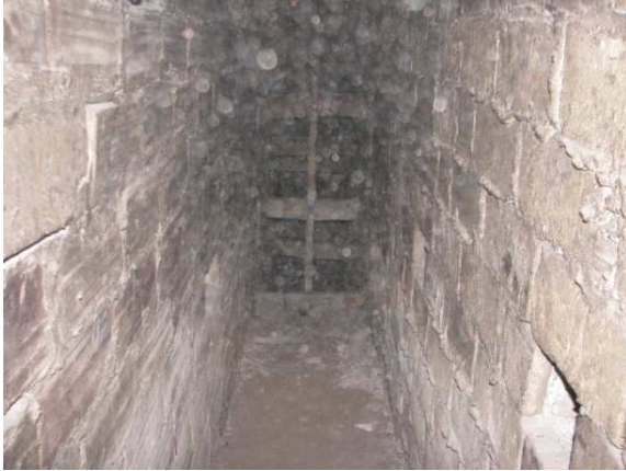
|Fig III.15. | : Detalle de los callejones de la cubierta
