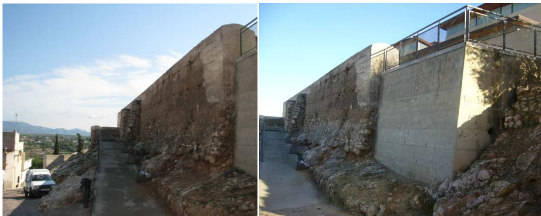
| Fig II.27. |: Vista de los restos de la muralla.
