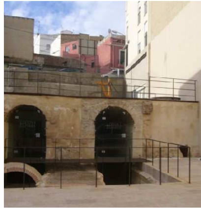
| Fig II.30. | : Vista actual de los baños árabes.
