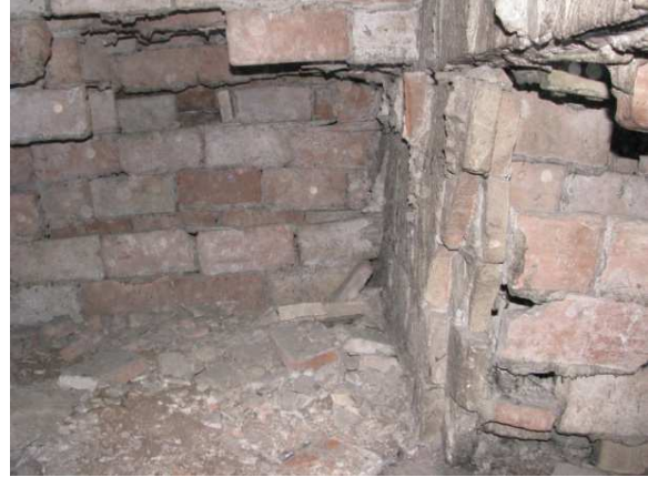
|Fig III.16. | : Detalle de los callejones de la cubierta
