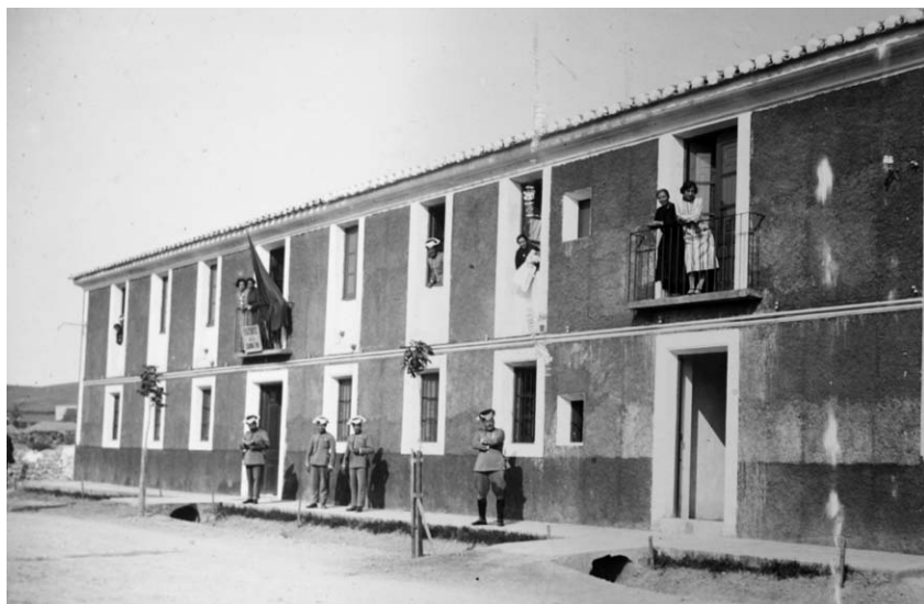
Tras varios años ocupando las instalaciones del lavadero de lanas de Calamocha, se construyó un nuevo cuartel de la Guardia Civil en la calle Zaragoza.
