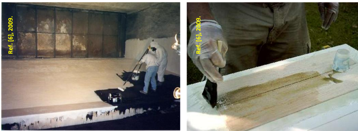
Figura - Anexo II.1 Moldeo por contacto a mano ( hand lay-up ).
