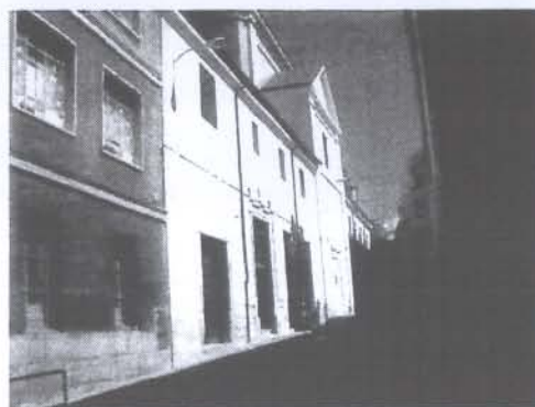
Fig. 8 Fachada principal. Antes y después de la obra de restauración (fuente: autor)
