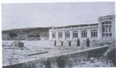
Fig. 12.—Depósito inferior del Canal Transversal en construcción ( Canal de Isabel II. Memoria sobre el estado de los diferentes servicios en 1911 y 1912 ).
