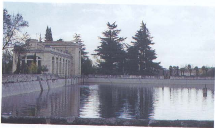
Fig. 10.-Vista exterior de la Central.
