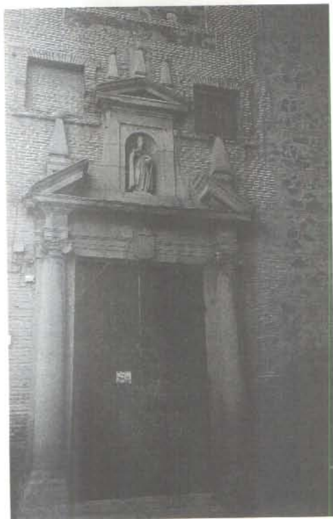
Fig 1. Puerta de acceso al Convento de San Clemente
