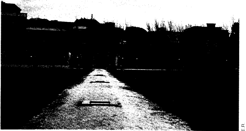
Fig. 31.-Eje central de la cubierta de césped del Depósito Mayor.
