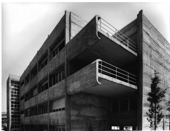
Figura 14. Miguel Fisac, Instituto de Química Orgánica, Madrid, 1964. Fundación Fisac.
