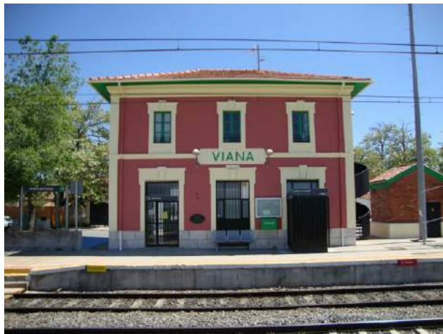
Figura 15, Edificio FFCC en Viana (Valladolid). Angel M a Fernández. Fuente: https://www.foro-ciudad.com/valladolid/viana-de-cega/fotos/207733-nuestra-estacion.html
