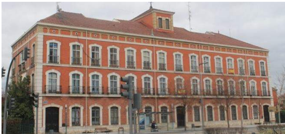
Figura 19. Residencia de oficiales de Farnesio. Valladolid. Fuente: Fotografía de autor.
