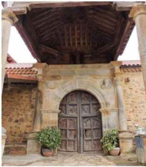
Armatura portico iglesia de Fuentencalada. MAMB, 2019.
