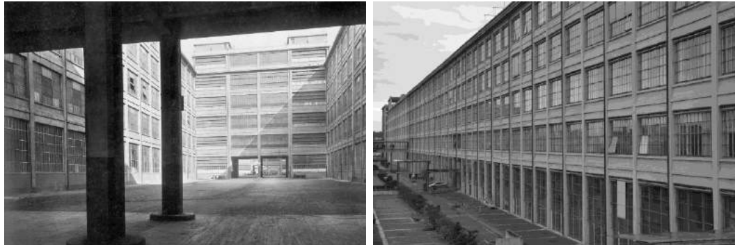
Figura 5. Patio interior Nouve Officine Fiat. Fachada (FIAT, 1989; archivo Ramos y Añón)
