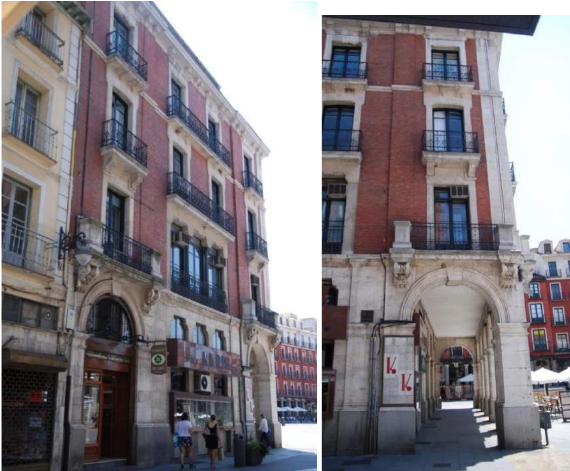
Figura 28. Detalles del Hotel Moderno, C/ Ferrari, 1. Fuente: Fotografías del autor.
