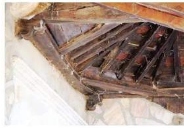
Armatura portico Brime de Urz. MAMB, 2019.
