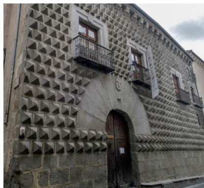
Figura 105. Imagen de fachada de casa de los picos en Segovia.
