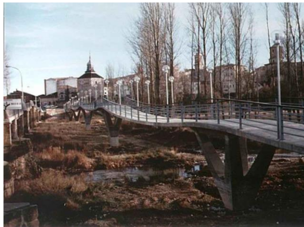
Figura 88. Fotografía pasarela banda-Tesa en Almazán (Soria)
