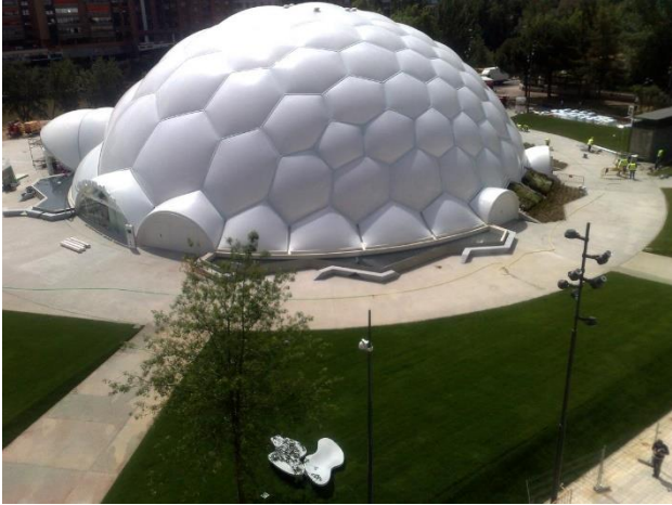
Figura 95. Imagen de La Cúpula del Milenio en Valladolid.
