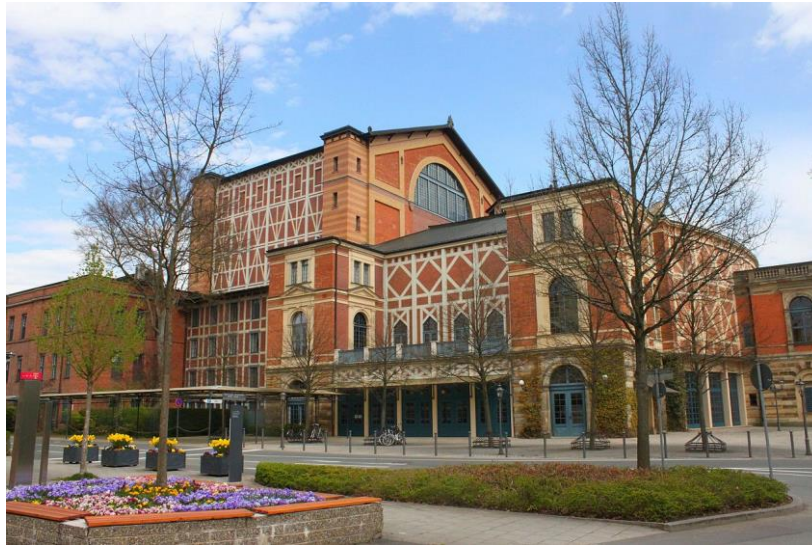
Figura 262. Vista exterior de la ópera Festspielhaus.
