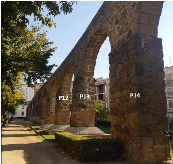
Figura 9. Pilares tipo 1 (desde P1 a P18) en el tramo 1 del acueducto. Fuente: elaboración propia (2021).
