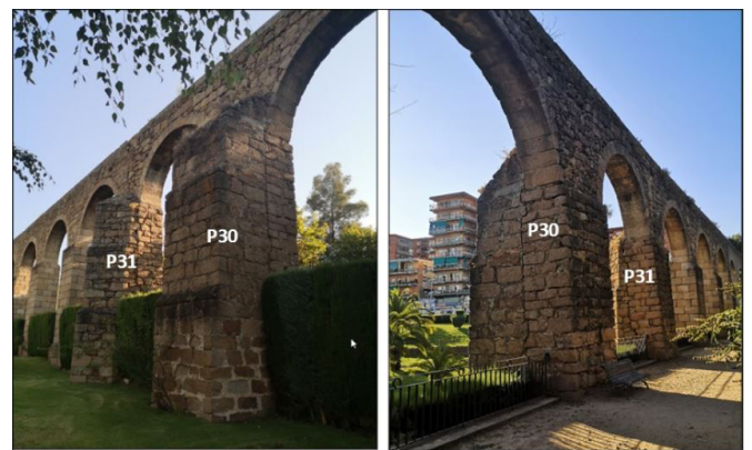
Figura 13. El pilar P30 desde la cara oeste y la cara este. Fuente: elaboración propia (2021).
