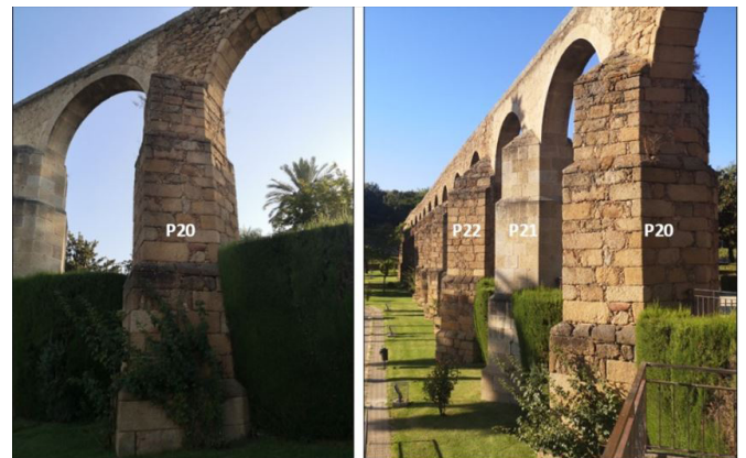
Figura 11. Pilares tipo 3 (P20-P29 exceptuando el P22) con tajamares que dotan a la base de una sección hexagonal. Fuente: elaboración propia (2021).
