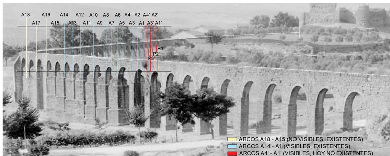
Figura 23. Fotografía del acueducto de San Antón en 1868 y replanteo del tramo perdido. Fuente: Jean Laurent y elaboración propia.
