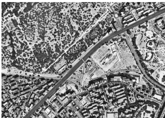
Figura 3.36: Vista aérea de la A-5 a su paso por la subestación eléctrica La Torre y la Casa de Campo, localización del 'punto de vista representativo' A5_5 (fuente: Google Maps, 2018).
