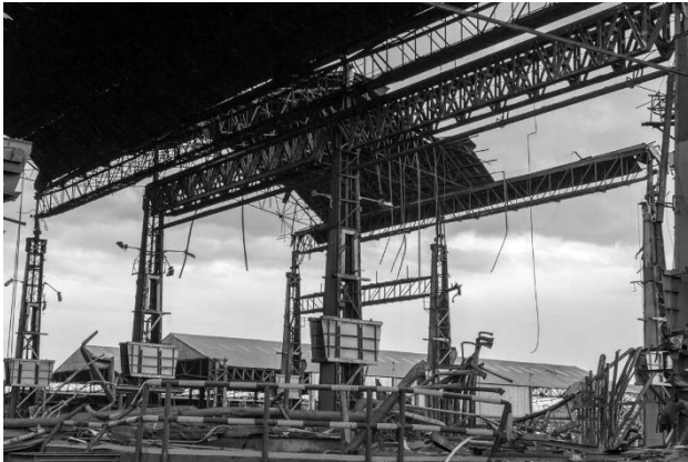
Figura 2.62: Desmantelado de la fundición de Arcelor-Mittal de Villaverde. Fotografía de Kike Rincón, 2015 (fuente: galería madridiario, www.madriario.es/album/8612/la-historia-de-la-fundicion-de-villaverde-en-imagenes ).
