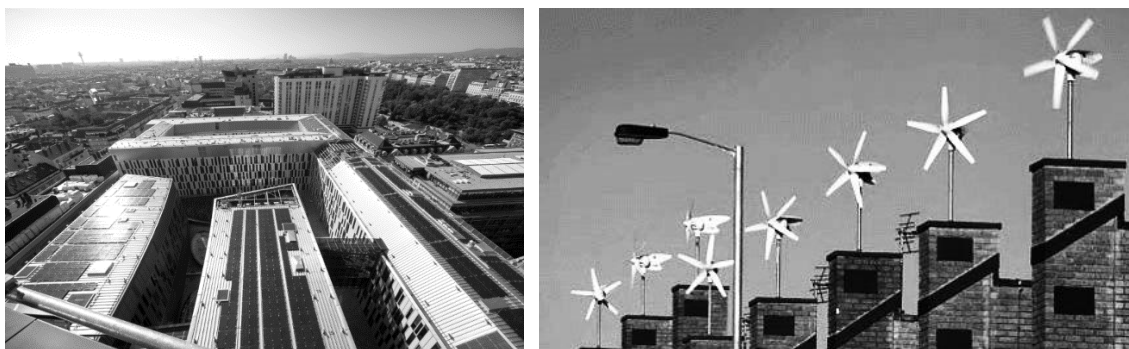
Figura 1.36: La energía renovable en el paisaje urbano. Izquierda: Paneles solares fotovoltaicos, ‘plantas solares comunitarias’, en las cubiertas de edificios de la ciudad de Graz. Wien Energie GmbH (fuente: smartcity.wien.gv.at/). Derecha: Instalaciones de mini-eólica en viviendas que utilizan un 20% de energía renovable en Croydon, Londres. Fotografía de 2009 de Peter Macdiarmid, Getty Images (fuente: theguardian.com/environment).
