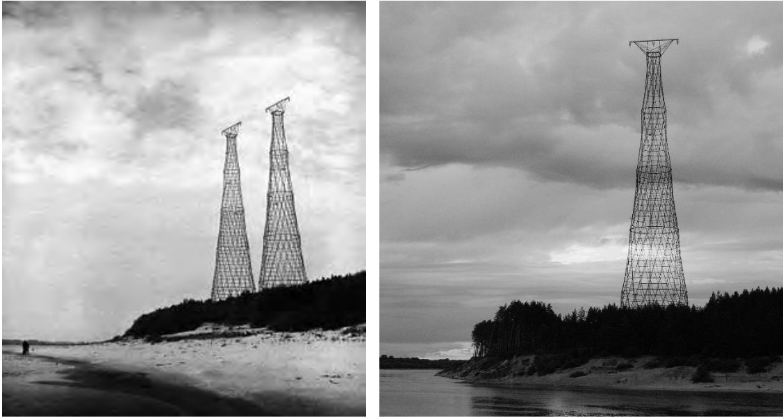
Figura 1.39: Torres de celosía de hiperboloides de 128m de altura, diseño de Vladímir Shukov de principios del siglo XX, junto al río Oka en Nizhny Nóvgorod, Rusia. Desde 2005, tan solo queda una en pie. Izquierda: fotografía de 1988. Derecha: fotografía de 2006. (fuente: Wikipedia).
