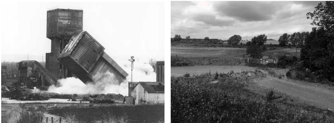
Figura 1.69: Izquierda: imagen de la demolición, en febrero de 1998, de las torres modernistas de la mina de Monktonhall, la última mina de gran profundidad que quedaba en la región de las Lothians. Las torres fueron diseñadas por Egor Riss, un arquitecto austrohúngaro quien, desde 1947, trabajó para la National Coal Board diseñando, durante los años cincuenta y sesenta, torres similares para seis minas de gran tamaño en Escocia. Todas ellas han sido demolidas. Derecha: vista actual del solar en el que se encontraba la mina de carbón de Monktonhall. (fotografía realizada por la autora en junio de 2017).
