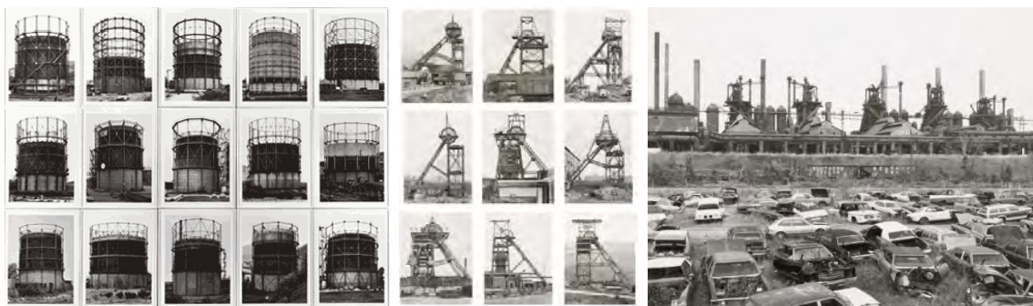
Figura 1.28: Fotografías realizadas por Bernd y Hilla Becher durante sus viajes por Europa y EE.UU. desde 1959 fotografiando paisajes y artefactos industriales. Izquierda: Gas-holders Germany, Belgium, France, Britain, USA , 1966-93 (fuente: www.tate.org.uk ). Centro: Winding Towers , 1966-97 (fuente: www.moma.org ). Derecha: Ensley, Alabama, United States , 1982 (fuente: www.moma.org ). 247
