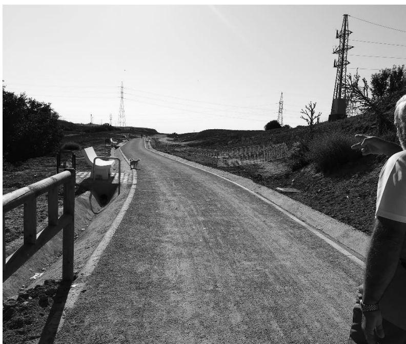
Figura 3.47: Fotografía tomada durante el trabajo de campo en torno a la subestación eléctrica de Villaverde (septiembre 2018).
