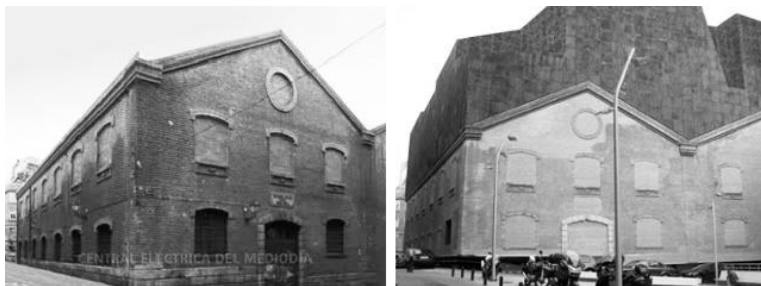
Figura 1.30: Izquierda: Estación eléctrica de Mediodía en su época de abandono. Derecha: edificio reconvertido en CaixaForum Madrid (fuente: www.rayosycentellas.net ).
