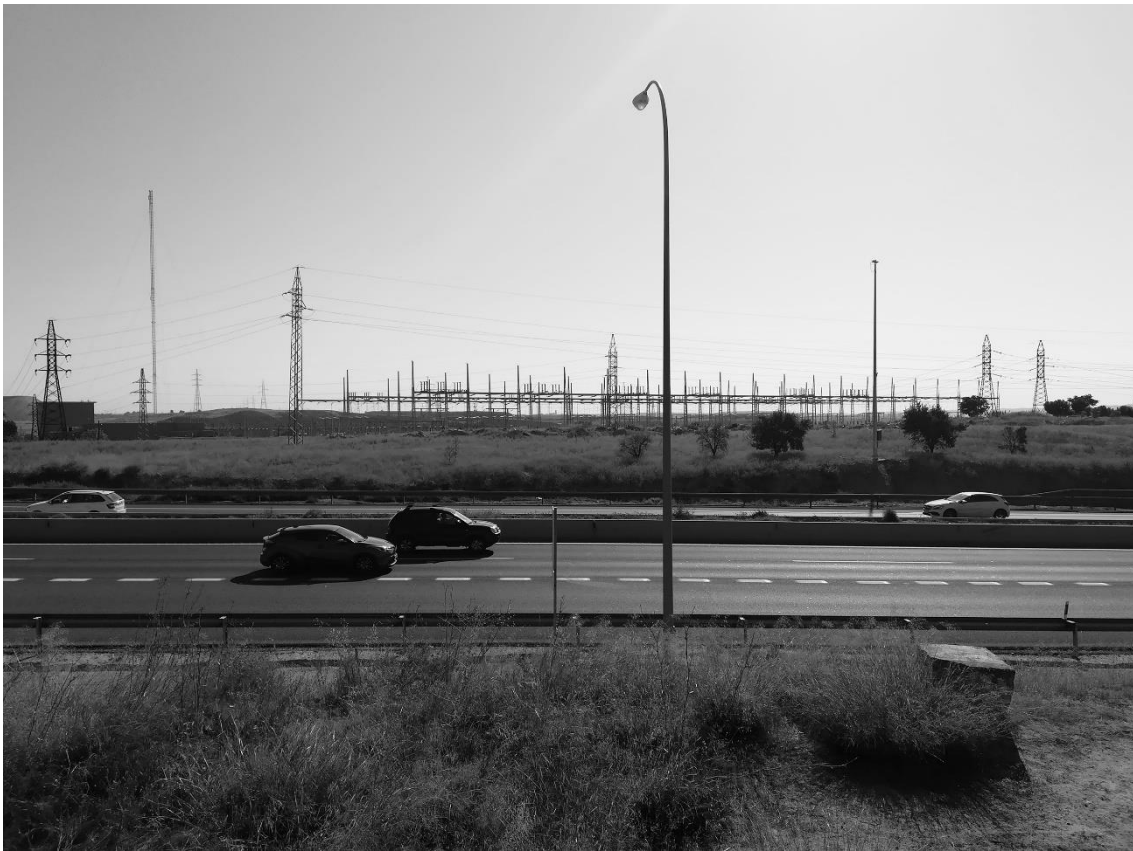
Figura 0.1: Vista de la A-4, carretera de Andalucía. Al fondo, la subestación eléctrica de Villaverde. Fotografía tomada durante el trabajo de campo (mayo 2018).
