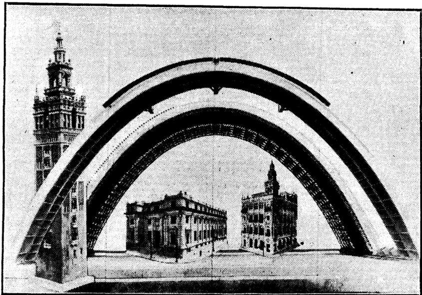
Las obras del aeropuerto terminal de Sevilla. He aquí las proporciones comparadas del hangar con la Giraldá y los edificios del Banco de España y de Telefónos en la capital andaluza. El hangar tiene 60 metros de alto, por 130 de ancho y 280 de largo. (Fot. Dubois.)
