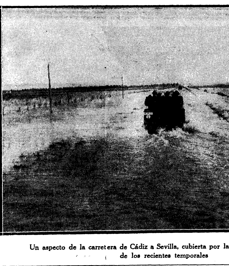
Un aspecto de la carretera de Cádiz a Sevilla, cubierta por las aguas a consecuencia de las recientes temporales. Fot. Dubols.
