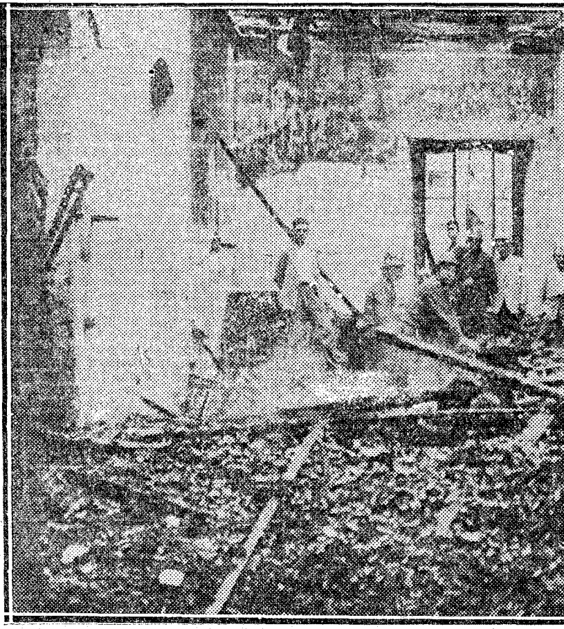
SEVILLA. Estado de la fábrica de corchos de Santa Paula, después del incendio (Pot. Olmedo)
