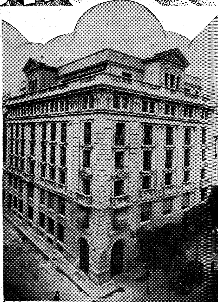
Edificio de EL DEBATE, en el que ha hecho todas las instalaciones sanitarias la Casa "Corcho e Hijos"
