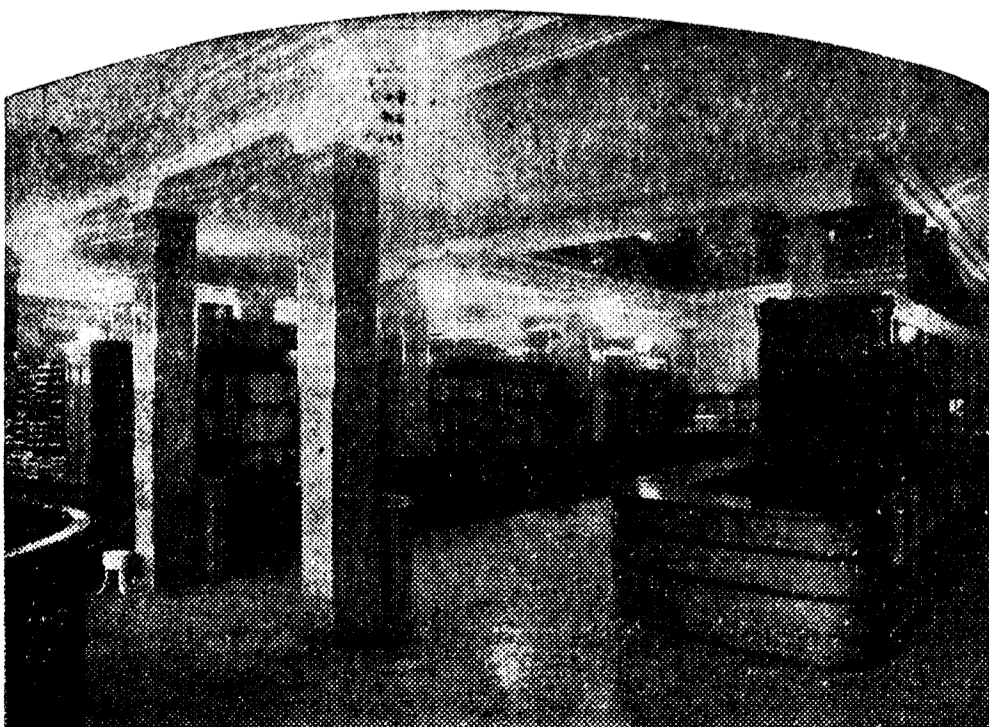
Otro aspecto de la nueva Casa Prast, cuya estructura metálica es obra de Torres, Sociedad Anónima
