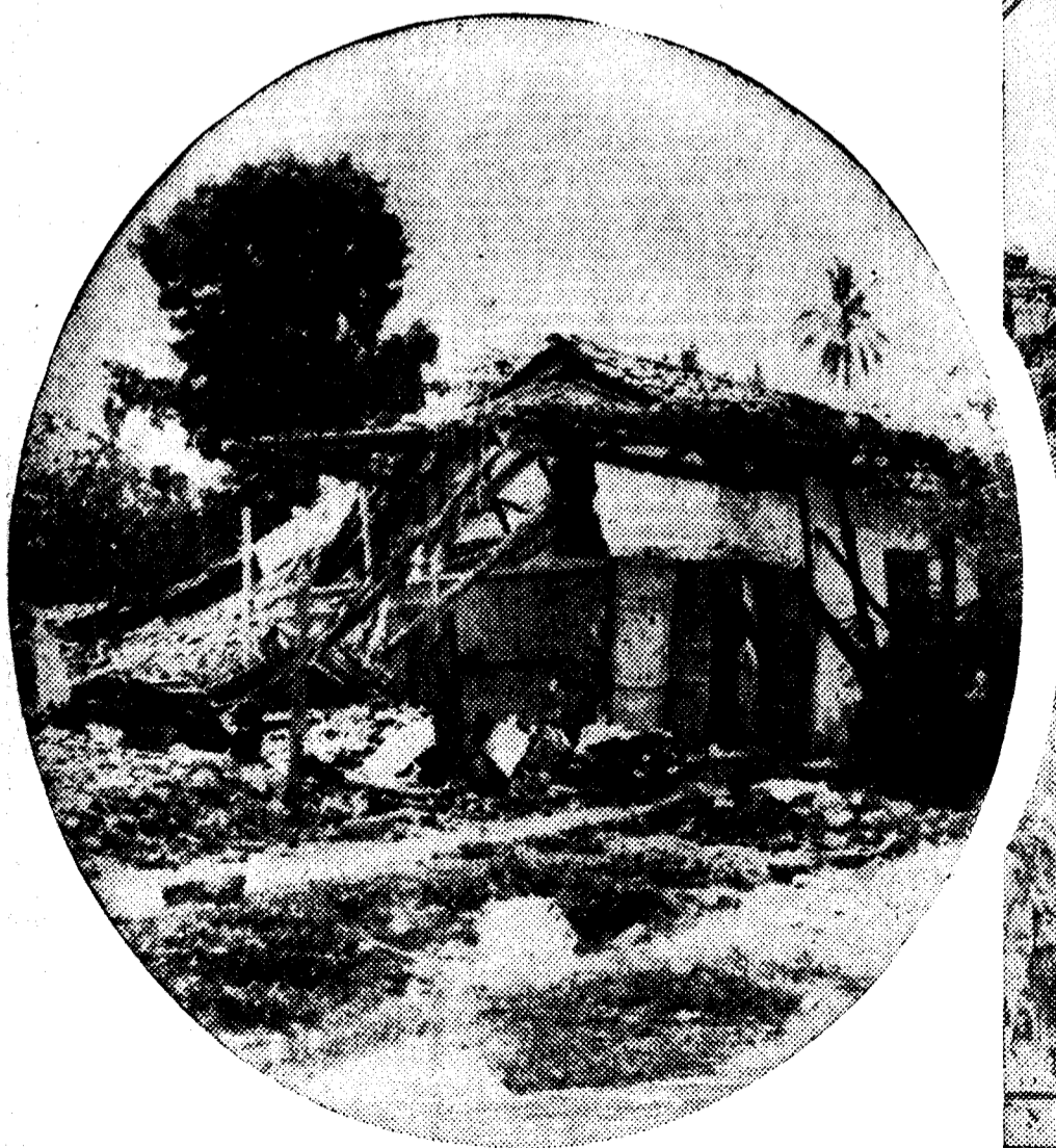
La comarca de David, Panamá, acaba de sufrir repetidos temblores de tierra, que han producido grandísimos daños. He aquí una casa de campo después de los fenómenos sísmicos
