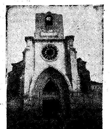
Estado actual de las obras de ampliación del templo de San Juan.
