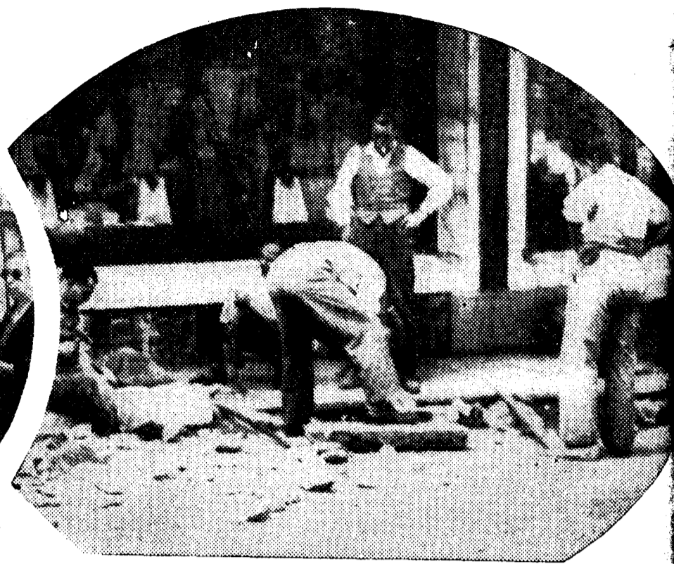
Los obreros municipales trabajan ya en la pavimentación de las calles
